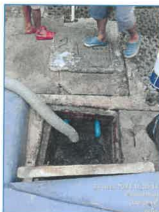
ภาพถ่ายที่ 2.2-10 การสูบน้ำไขมันส่งกำจัด
