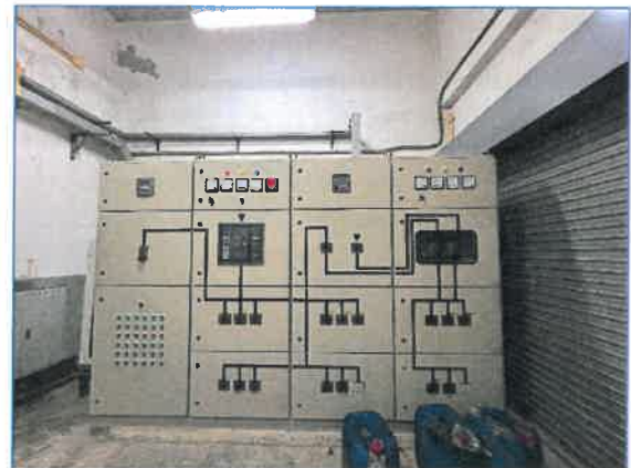
MDB และ Circuit Breaker ของโครงการ
