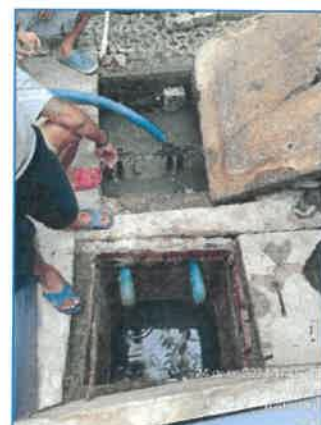
ภาพถ่ายที่ 2.2-10 การสูบน้ำไขมันส่งกำจัด
